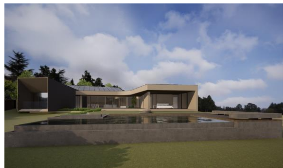
Figura 99: Habitação Corredoura, vista sul. Fonte: FSA.
