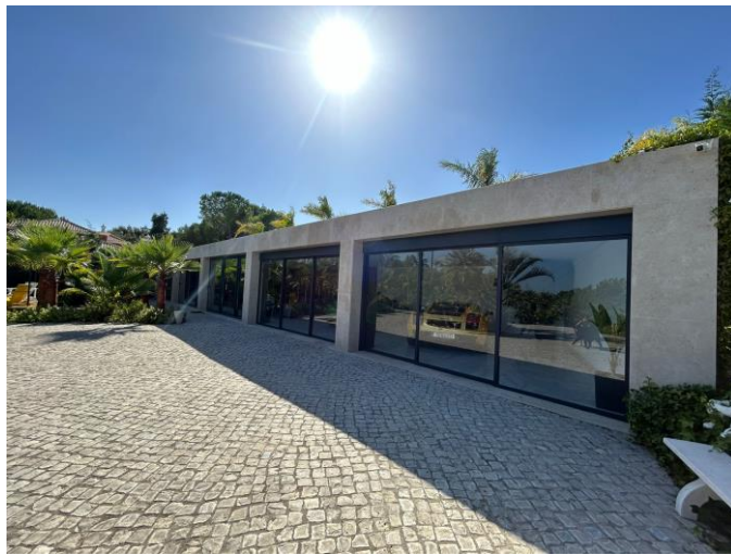
Figura 26: Anexo social, vista exterior. Fonte: autora.
