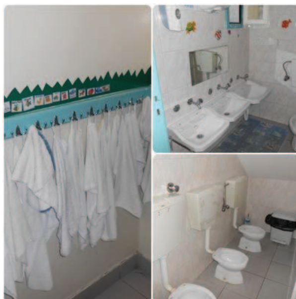
Figura 2 - Instalações sanitárias da Sala das Borboletas e da Sala das Abelhinhas
