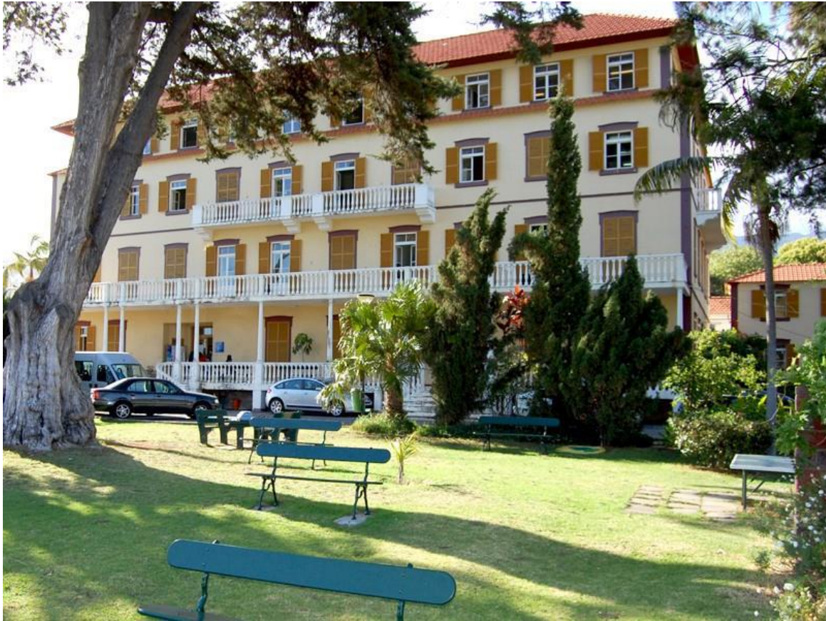
Figura 1- Sede de Conservatório-Escola Profissional das Artes Engº Peter Clode situada no Funchal
