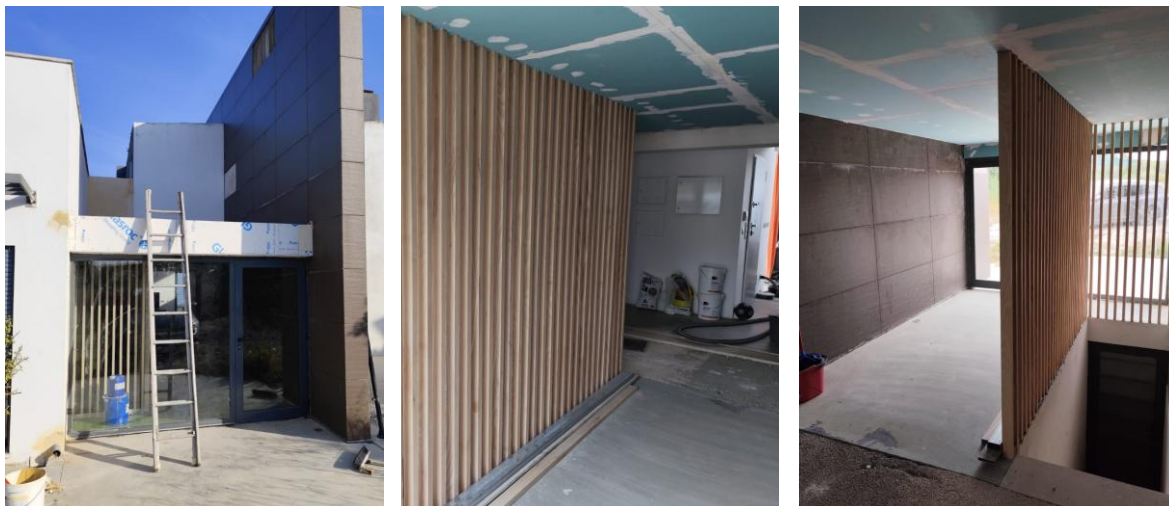
Figura 73 Registo fotográfico de obra - Piso 0 (PDI Casa da Azóia)
