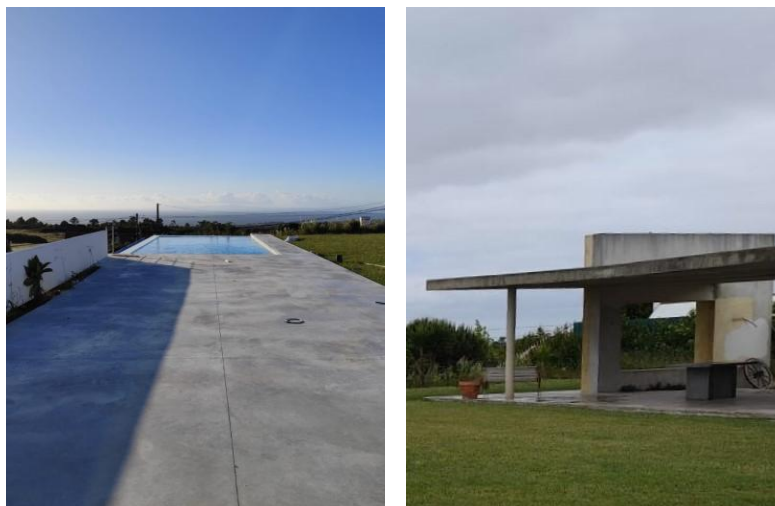
Figura 74. Registo fotográfico de obra - Exterior (PDI Casa da Azóia)
