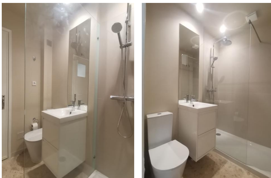
Figura 102. Registo fotográfico - Instalação sanitária - 26.jul.2024 (Apto. R. Diogo de Couto)
