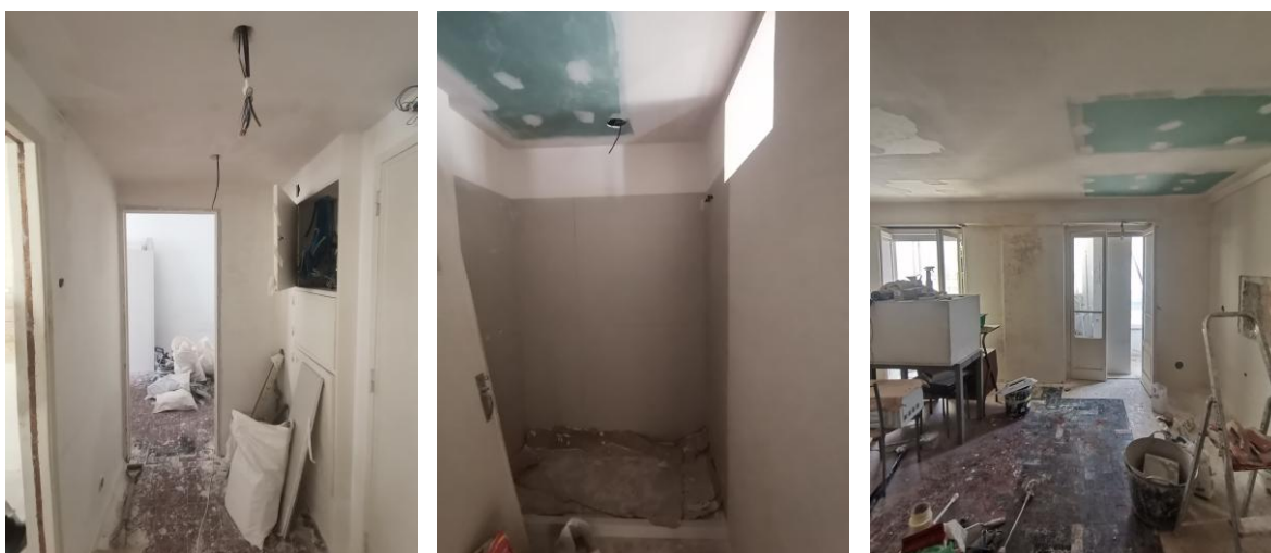
Figura 94. Registo fotográfico de obra - 21.jun.2024 (Apto. R. Diogo de Couto)
