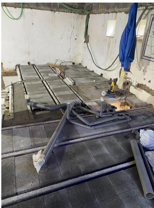
Figura 52 - Levantamento fotográfico. Acompanhamento de obra. Fonte: autor.
