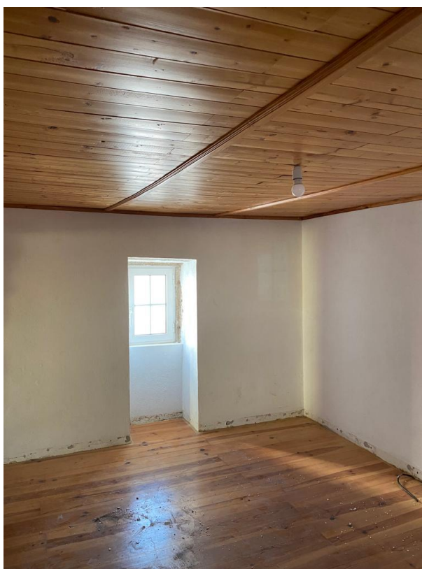
Figura 48 - Levantamento fotográfico. Visita ao local. Fonte: autor.
