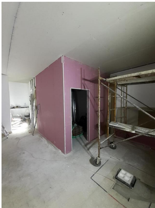
Figura 18 - Levantamento fotográfico. Acompanhamento da obra. Fonte: autor.
