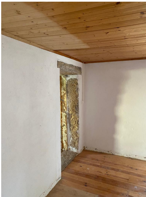
Figura 49 - Levantamento fotográfico. Visita ao local. Fonte: autor.
