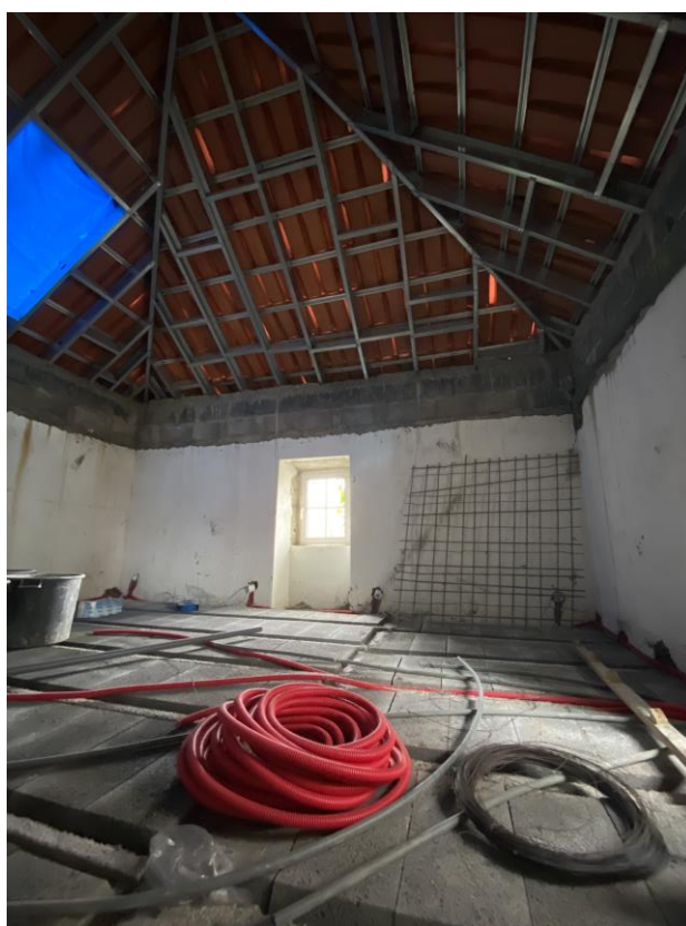
Figura 50 - Levantamento fotográfico. Acompanhamento de obra. Fonte: autor.
