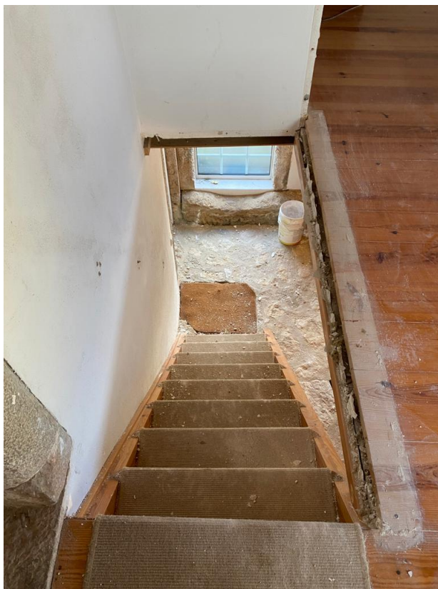
Figura 47 - Levantamento fotográfico. Visita ao local. Fonte: autor.
