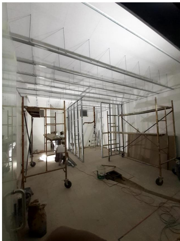
Figura 17 - Levantamento fotográfico. Acompanhamento da obra. Fonte: autor.
