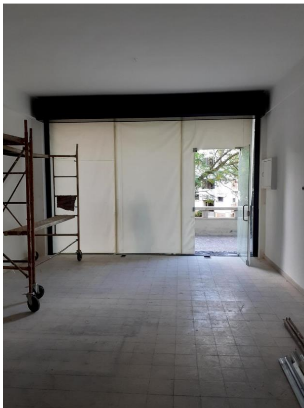
Figura 16 - Levantamento fotográfico. Acompanhamento da obra. Fonte: autor.
