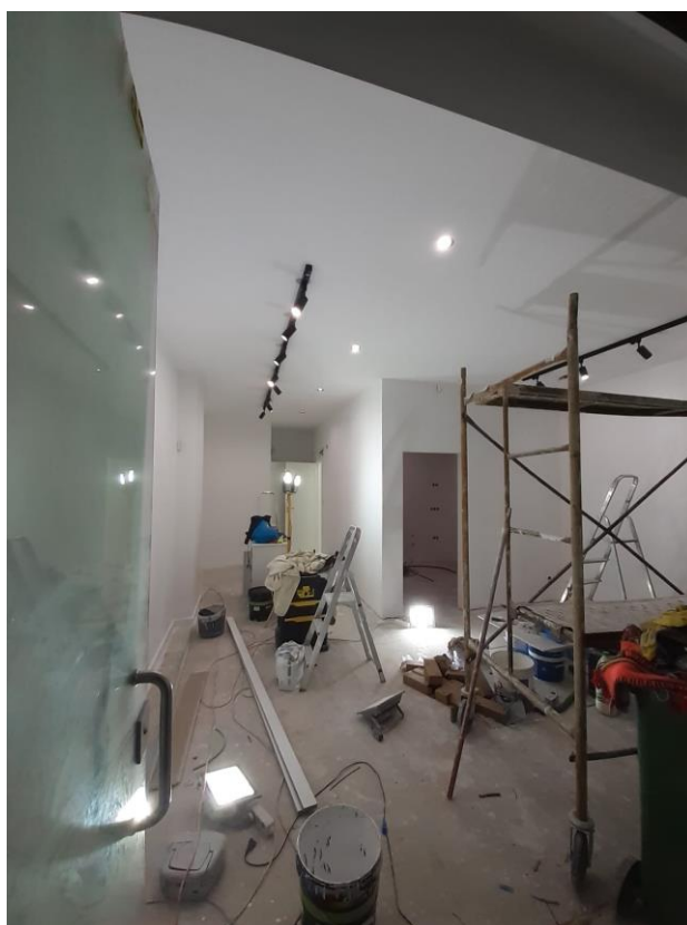
Figura 19 - Levantamento fotográfico. Acompanhamento da obra. Fonte: autor.
