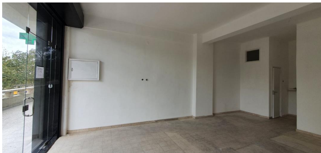
Figura 9 - Levantamento fotográfico. Fonte: autor.
