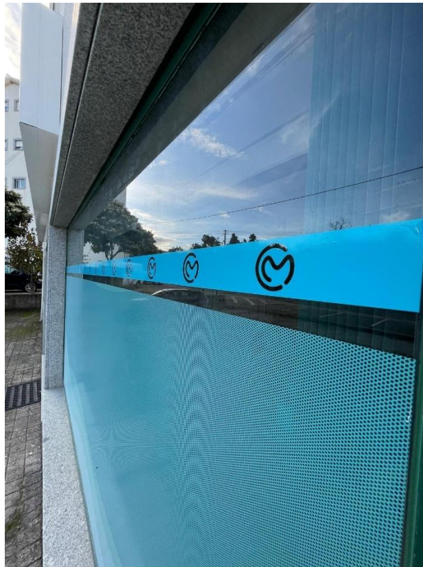
Figura 155 - Pormenor do vinil de recorte e do vinil microperfurado, 2024 (Fonte: WD Retail)
