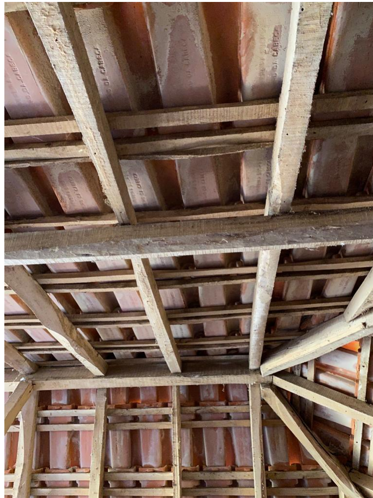
Figura 62 - Visita ao local. Telhado existente
