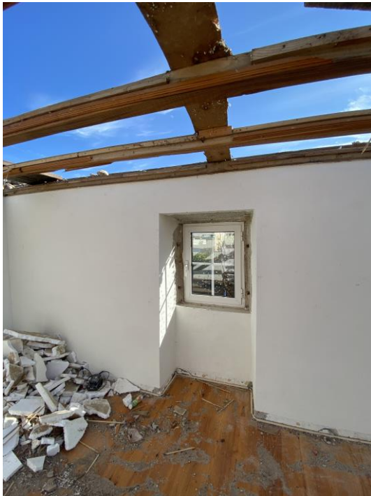
Figura 14 - Acompanhamento da obra. Fonte: autor
