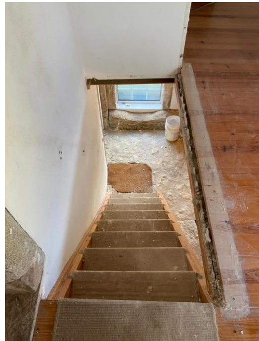
Figura 61 - Visita ao local. Imagem da escada de acesso ao piso superior do anexo. Fonte: autor
