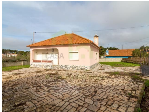
Figura 80 - Imagem do edificado já existente. Fonte: Casa das Casas
