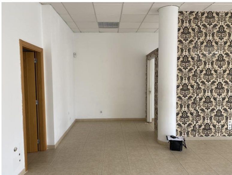
Figura 55 - Espaço interior alvo de projeto. Retificação de medidas. Visita ao local. Fonte: autor
