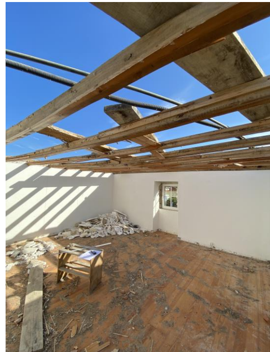
Figura 7 - Medição em obra. Fonte: autor
