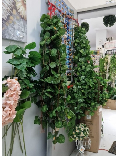
Figura 1: Porta corta-fogo obstruída
