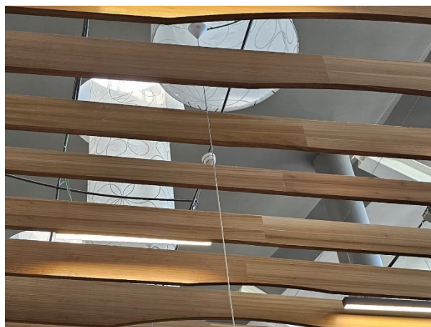
Figura 4: Detetor mal posicionado
