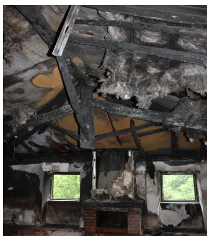
Figura 4: Local ao lado da lareira, onde o revestimento, a lã mineral e o enchimento do painel sanduíche foram completamente consumidos, na sala de estar.
