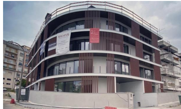
Figura 46- Edifício Habitacional, Leiria. Fonte: 2L' atelier
