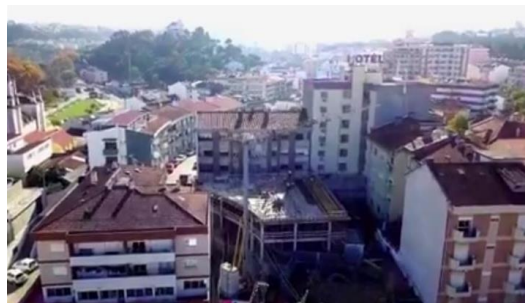
Figura 100- Construção do edifício:11 Novembro 2020. Fonte: 2L'atelier
