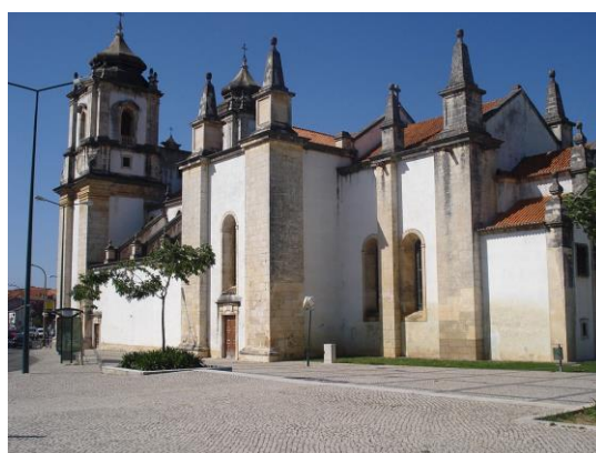
Figura 38- Convento de Santo Agostinho, antes da reabilitação. Fonte: https://www.wikiwand.com/pt/Igreja_e_convento_de_Santo_Agostinho_(Leiria)
