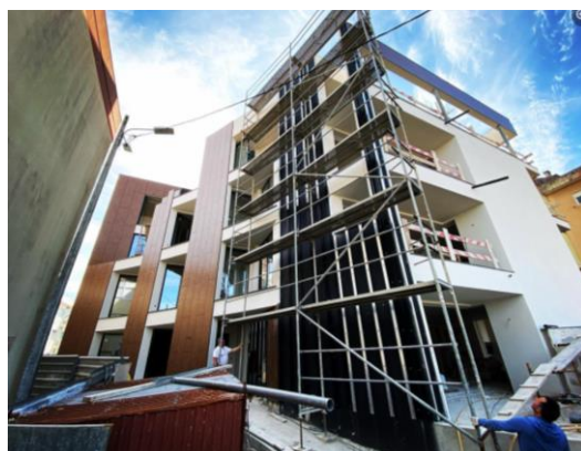
Figura 101- Construção do edifício: 27 Outubro de 2021. Fonte: 2L'atelier
