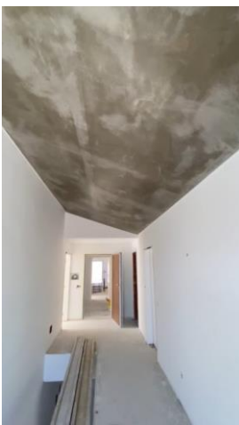
Figura 188- Fotografia Corredor (11). Autor: Eduardo Rodrigues
