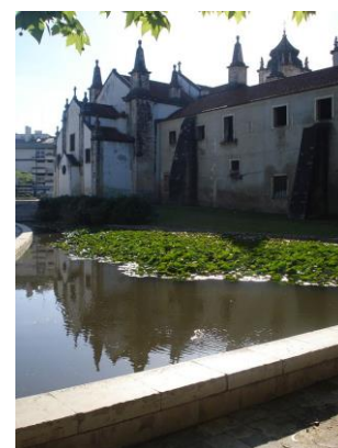
Figura 39- Convento de Santo Agostinho, antes da reabilitação. Fonte: https://www.wikiwand.com/pt/Igreja_e_convento_de_Santo_Agostinho_(Leiria)
