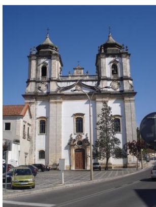
Figura 37- Convento de Santo Agostinho, antes da reabilitação. Fonte: https://www.wikiwand.com/pt/Igreja_e_convento_de_Santo_Agostinho_(Leiria)
