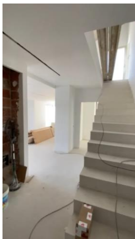
Figura 129- Fotografia Hall de Entrada. Autor: Eduardo Rodrigues
