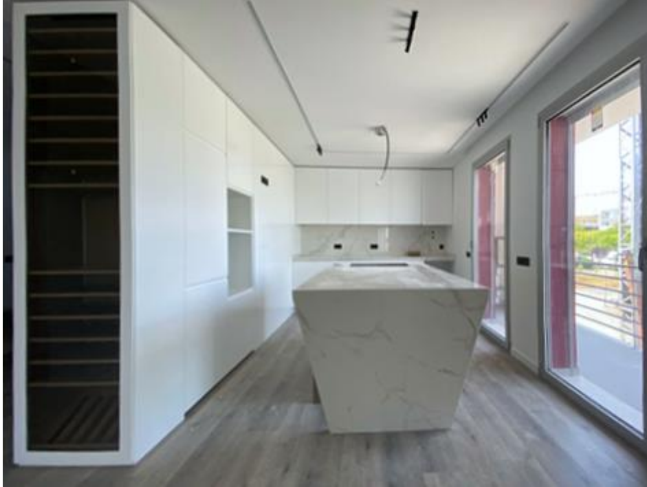
Figura 150- Fotografia da Cozinha no decorrer da obra. Autor: Eduardo Rodrigues
