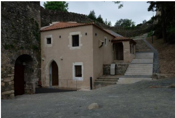
Figura 16- Casa do Guarda, depois da reabilitação. Fonte: https://www.jornaldeleiria.pt/noticia/as-primeiras-imagens-da-igreja-da-pena-e-do-castelo-de-leiria-depois-das-obras
