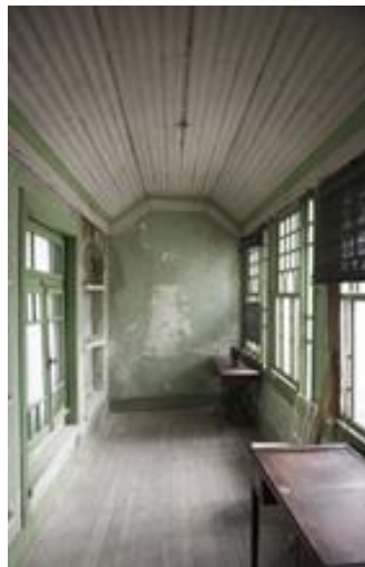
Figura 24- Casa do Arco- fotografia interior. Fonte: https://sites.ipleiria.pt/matematicaporleiria/praca-rodrigues-lobo/
