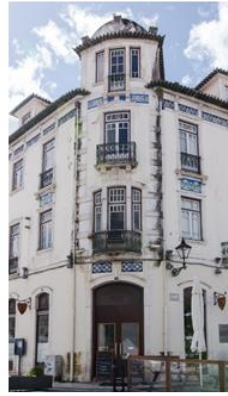
Figura 21- Edifício Zúquete. Fonte: https://sites.ipleiria.pt/matematicaporleiria/praca-rodrigues-lobo/
