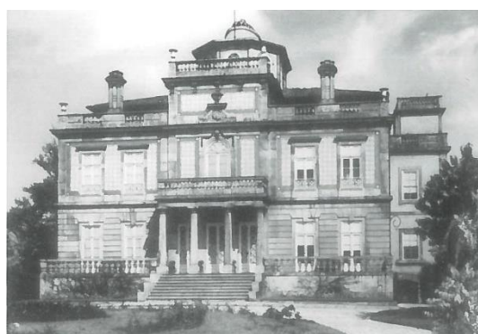
Figura 7 - Antigo edifício do CMP (Palacete)
