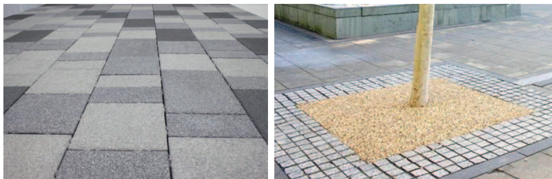
Figura 17 - Exemplos de pavimentos de betão drenante [25][26]
