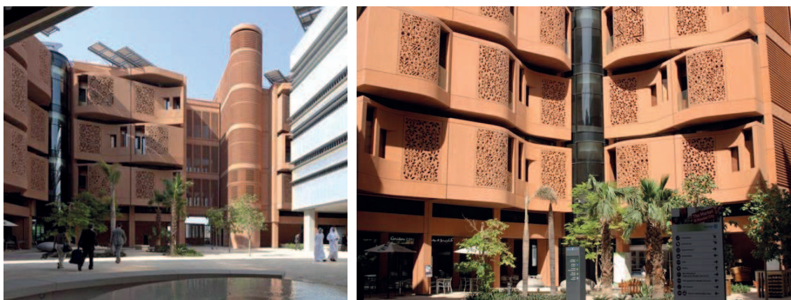
Figura 25 - Forma das fachadas dos edifícios em Masdar, Emirados Árabes Unidos [38][39]
