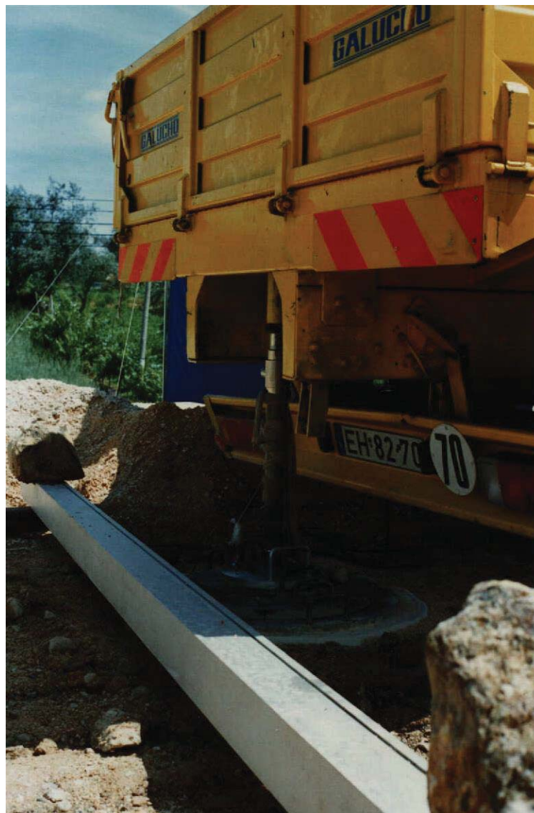
FIGURA 5.8- Pormenor do conjunto de placas utilizado no Ensaio de Carga com Placa de Carregamentos Repetidos.
