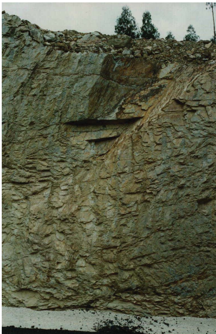
FIGURA 5.11- Aspecto do material nas proximidades do km 0+600.
