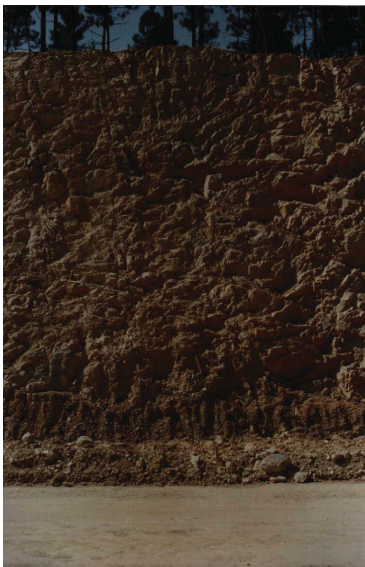
FIGURA 5.10 - Aspecto do material ao km 4+350
