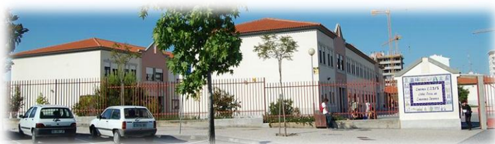
Figura 8 - Escola EB 2/3 João Roiz de Castelo Branco
