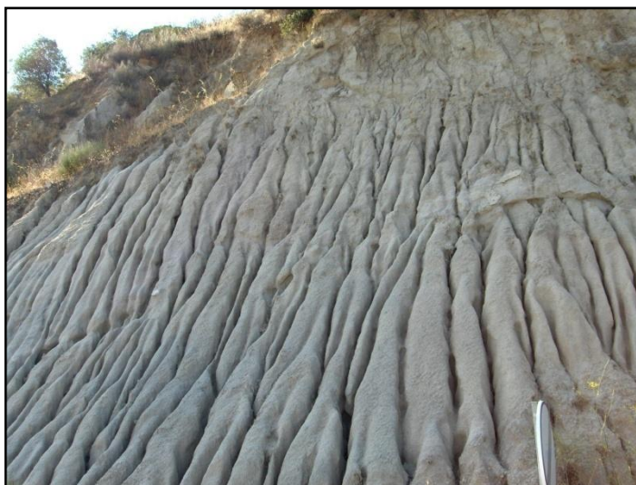
Figura 11 - Área com alguns sintomas de erosão, junto a Longroiva
