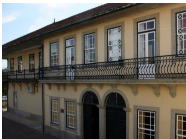
Figura 2 - Fachada da Academia de Música de Castelo de Paiva
