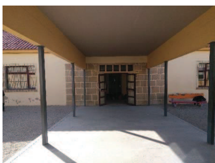
Figura 95 - Rampa de acesso ao ginásio e ao refeitório
