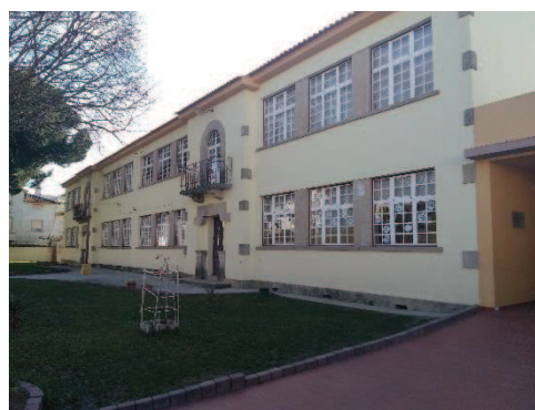
Figura 87 - Parte da frente da escola
