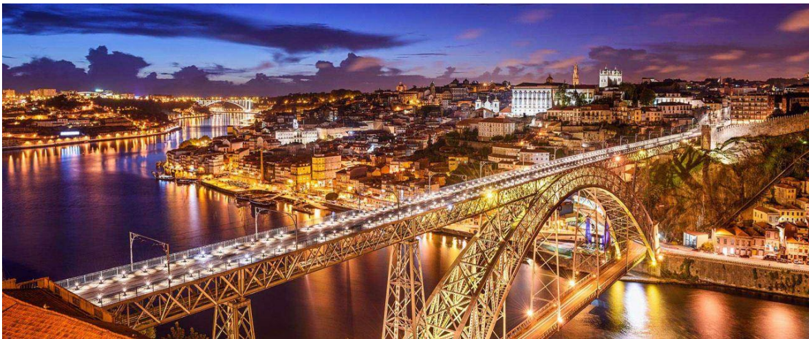
Figura 4- Ponte D. Luís I. Fonte: Universidade Católica Portuguesa
