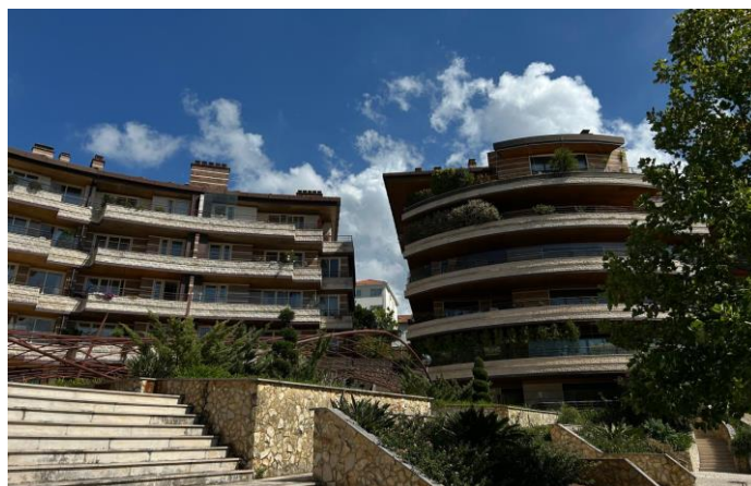
Figura 42 - Fotografia do edifício onde esta inserido o atelier. Fonte: Autora.
