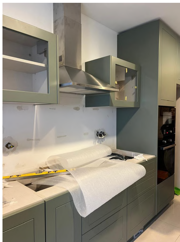
Figura 194 - Fotografia do processo de instalação das bancadas. Fonte: Autora.
