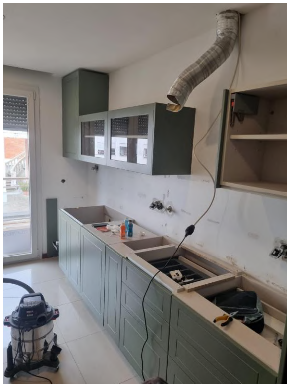
Figura 193 - Fotografia do processo de instalação da carpintaria. Fonte: Autora.
