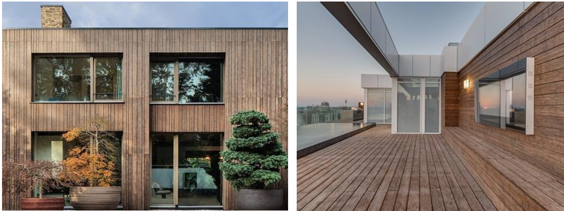
Figura 61 - Imagens de demonstração da aplicação do material Moso Bamboo em fachadas exteriores e decks. Fonte: Banemawoods.pt
