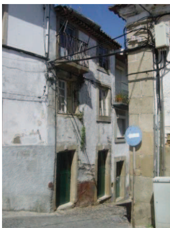
Figura 33 - Rua dos Peleteiros nº32 e 34, edifício a recuperar.
