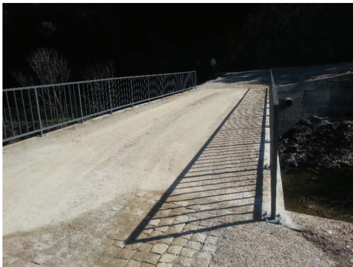
Figura 11 - Pontão das Sarzedas, obra em finalização.
