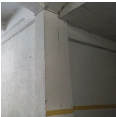
Figura 50 - junta de dilatação entre os edifícios.
