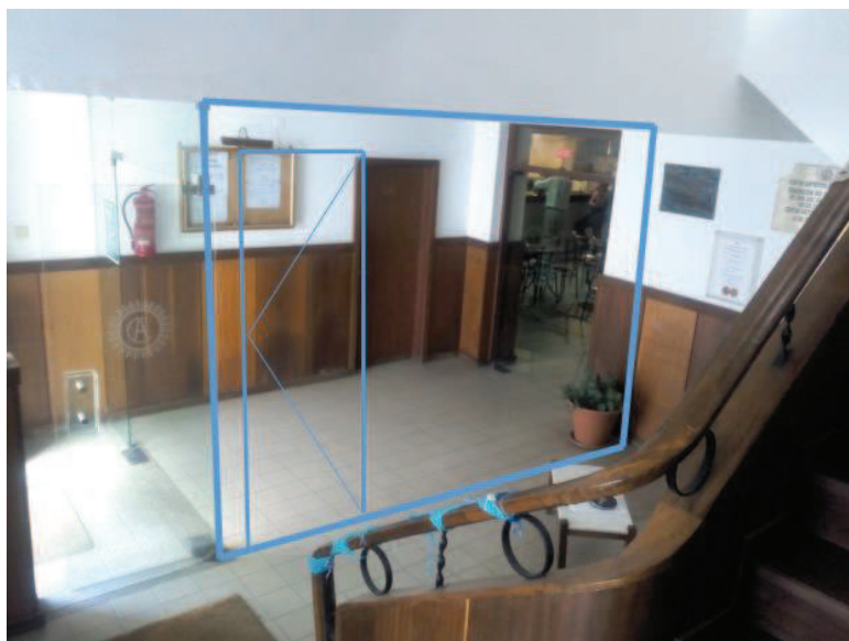
Figura 20 - Hall de entrada, piso 0.
