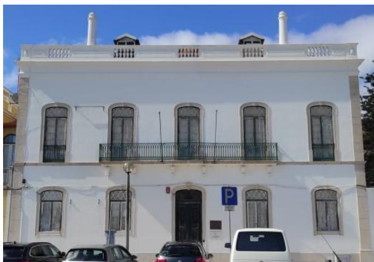
Figura 6 - Conservatório de Música David Sousa, Figueira da Foz
