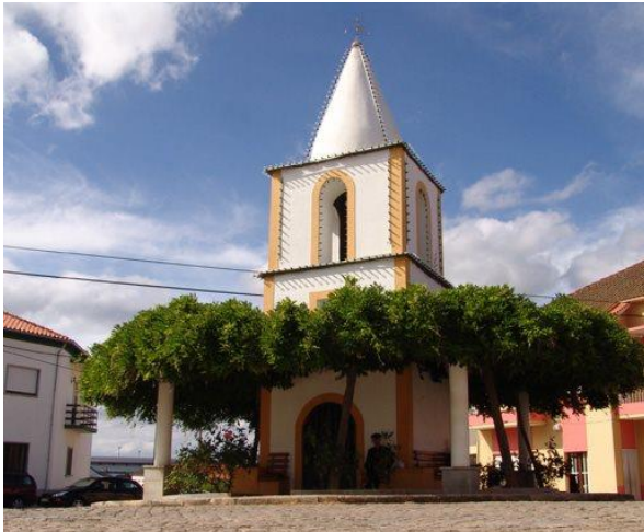
Figura 7 - Torre do Adro.
