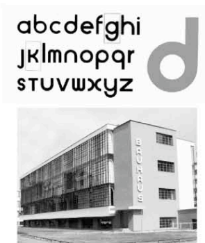
Sturm Blond, 1925, de Herbert Bayer y edificio de la Bauhaus en Dessau
