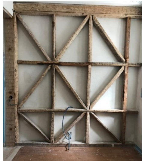
Figura 31 – Estante em madeira existente
