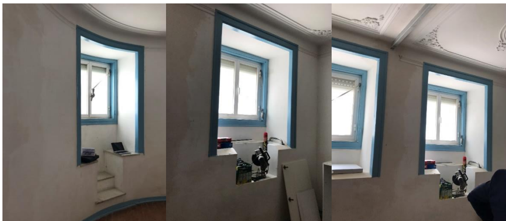
Figura 29 – Pormenor de janelas
