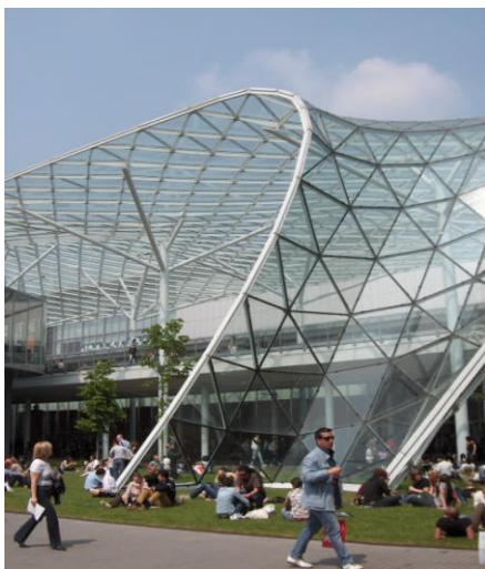
Fig. 4.52 – Cobertura de passadiços na Fiera Milano
