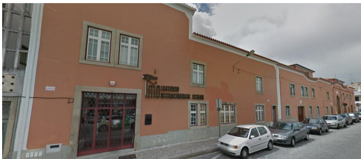
Figura 11 - Caso de estudo - Edifício da Santa Casa da Misericórdia, Rua da Quinta nova, Castelo Branco (Lar de Idosos, Clínica de oftalmologia)
