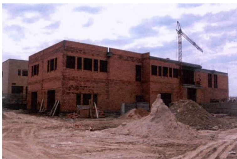
Figura 13- Bloco “D” em construção já com correção de pontes térmicas.
