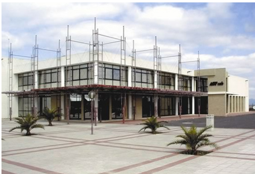
Fig. 028 Fachada principal do edifício da AERCAB. Fonte www.nercab.pt
