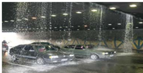
Figura 4 - Sistema cortina de água num parque de estacionamento (André Cunha)
