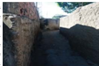
Figura 2 - Bairros suburbanos da cidade de Maputo sem vias de acesso para viaturas de socorro
