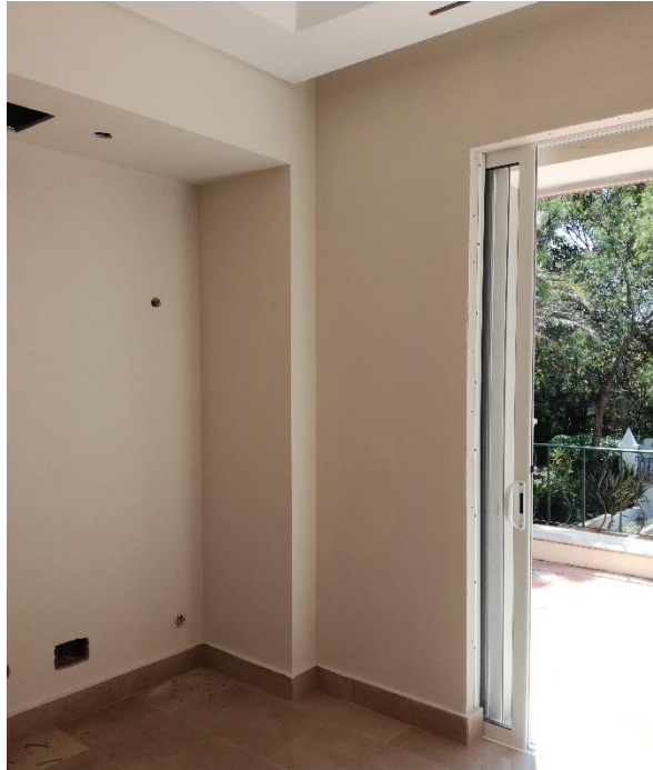
Figura 40 - Porta de correr fica completamente embutida na parede. FONTE: Cristina Popadia.
