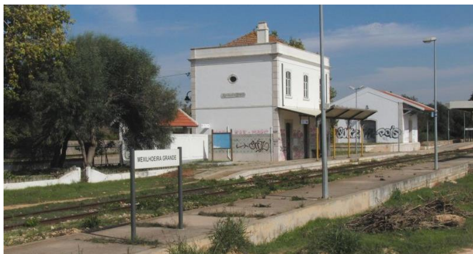
Figura 46 - Estação de comboio da Mexilhoeira Grande, Algarve.
