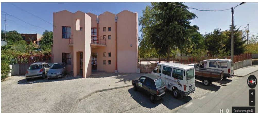
Figura 11: Fachada da Escola Básica da Boa Esperança-Castelo Branco.
