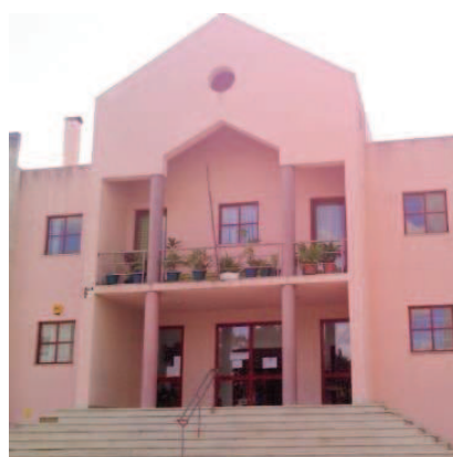
Figura 16: Fachada principal da EB1 da Quinta da Granja
