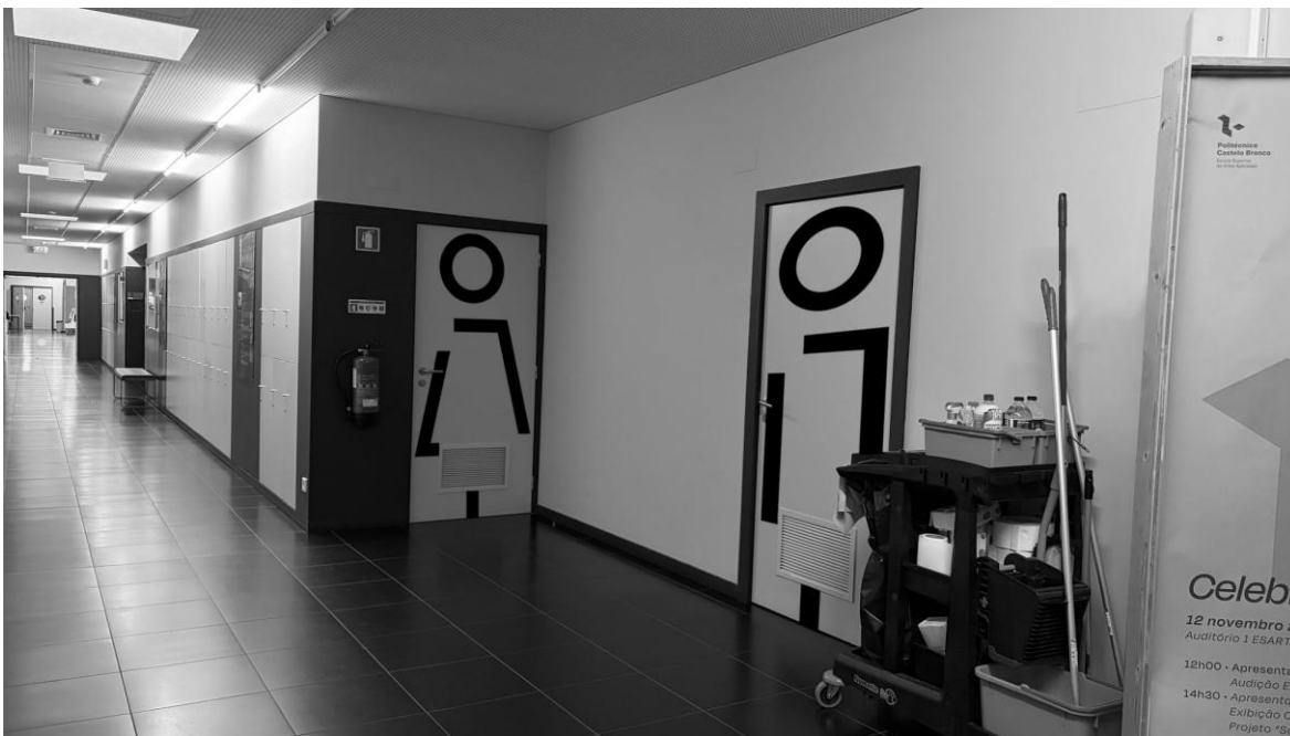
Figura 180 Posicionamento das placas interiores de identificação da zona dos sanitários. [Fonte: Autora, 2025].
