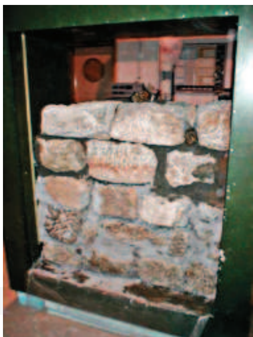
Figura 1 - Fase intermédia da construção da parede.
