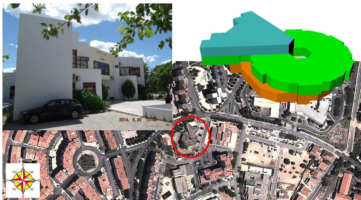
Figura 52 - Foto geral em cima e à esquerda, volumetria em cima e à direita e localização em baixo, do Centro de Saúde de S. Tiago.
