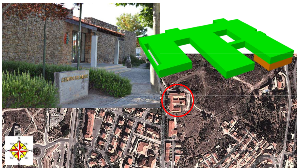
Figura 54 - Foto geral em cima e à esquerda, volumetria em cima e à direita e localização em baixo, do Centro de Saúde de Idanha-a-Nova.
