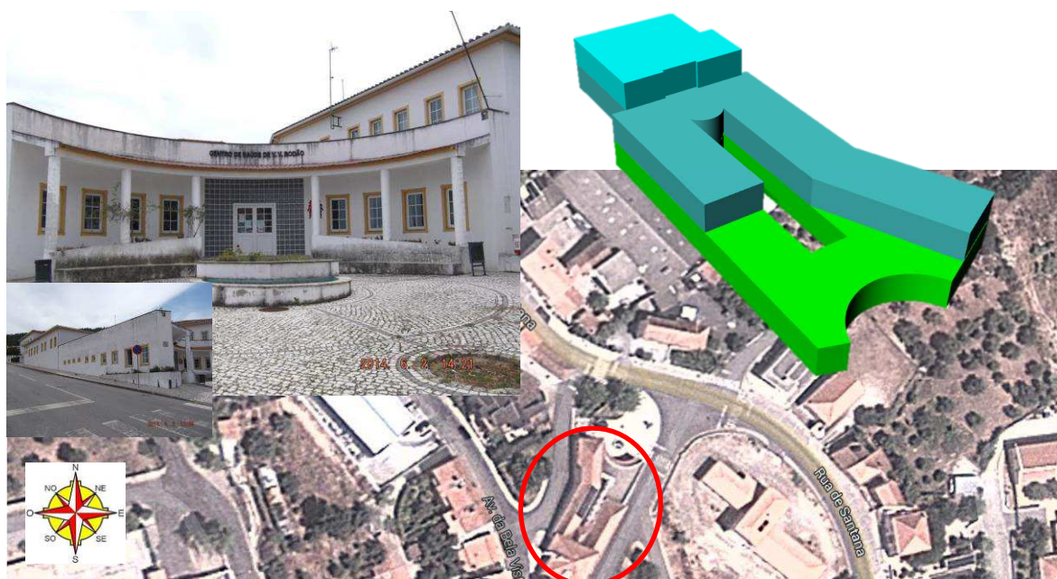
Figura 61 - Foto geral em cima e à esquerda, volumetria em cima e à direita e localização em baixo, do Centro de Saúde de Vila Velha de Ródão.
