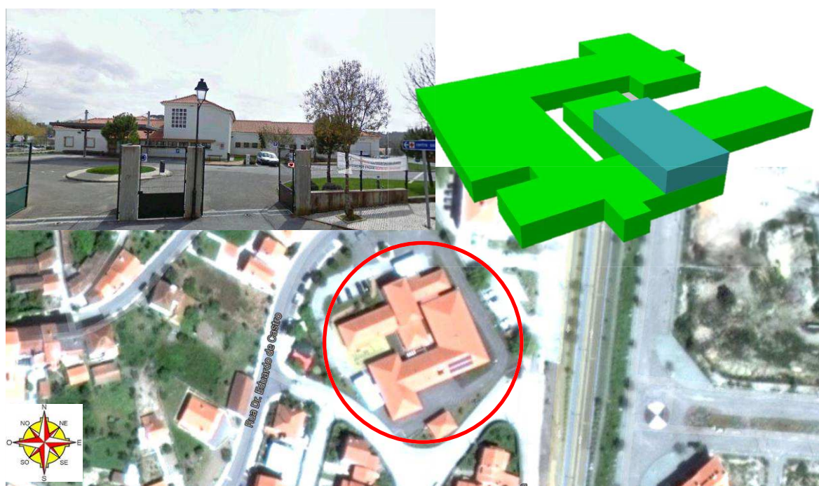
Figura 70 - Foto geral em cima e à esquerda, volumetria em cima e à direita e localização em baixo, do Centro de Saúde de Vila de Rei.
