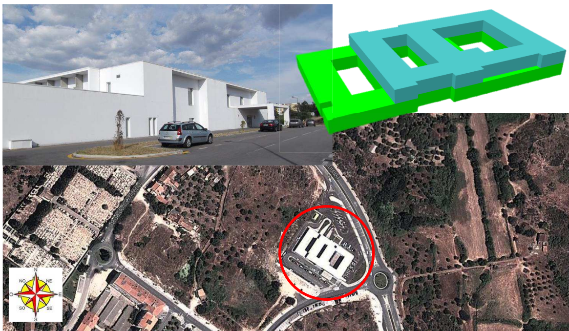
Figura 50 - Foto geral em cima e à esquerda, volumetria em cima e à direita e localização em baixo, do Centro de Saúde de S. Miguel.
