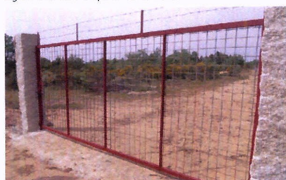
Fig. 5. Cerca fixa com pormenor de portão.
