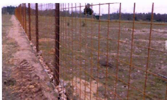
Fig. 3. Cerca fixa chumbada em pedra.
