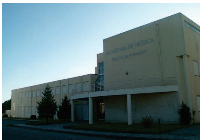
Figura 79 - Instalações da AMPB
