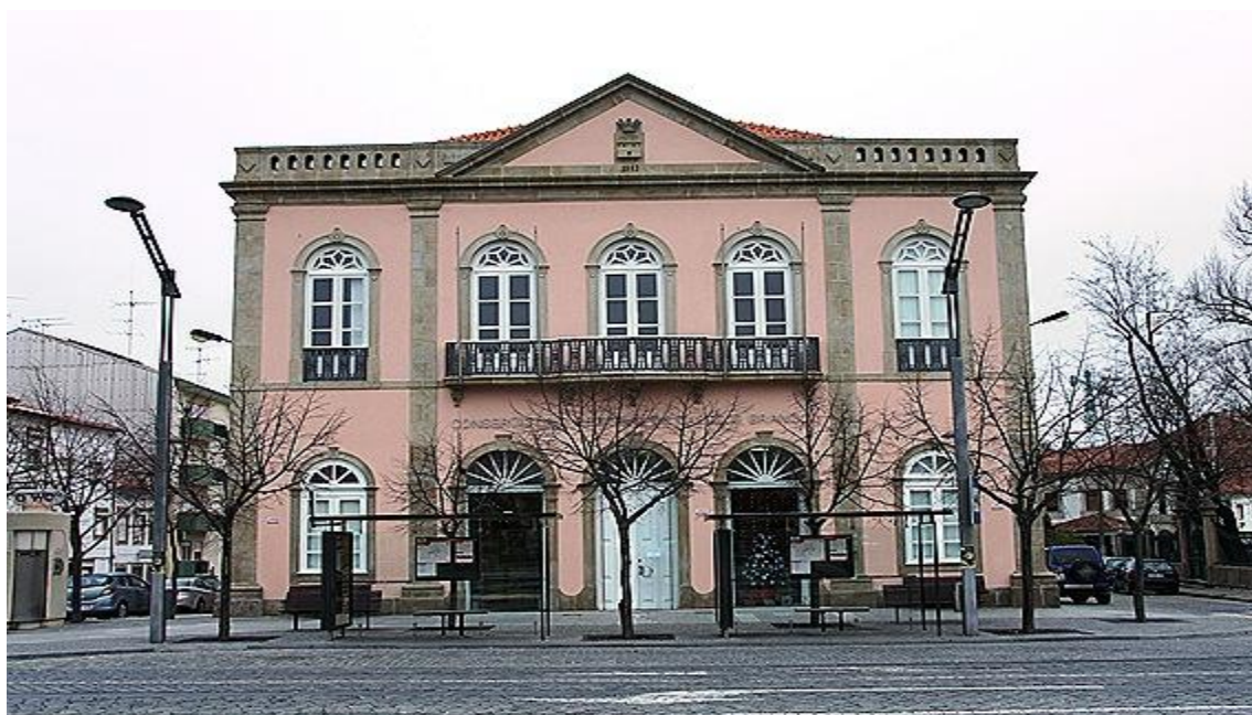
Figura 2 - Conservatório Regional de Castelo Branco - edifício sede.
