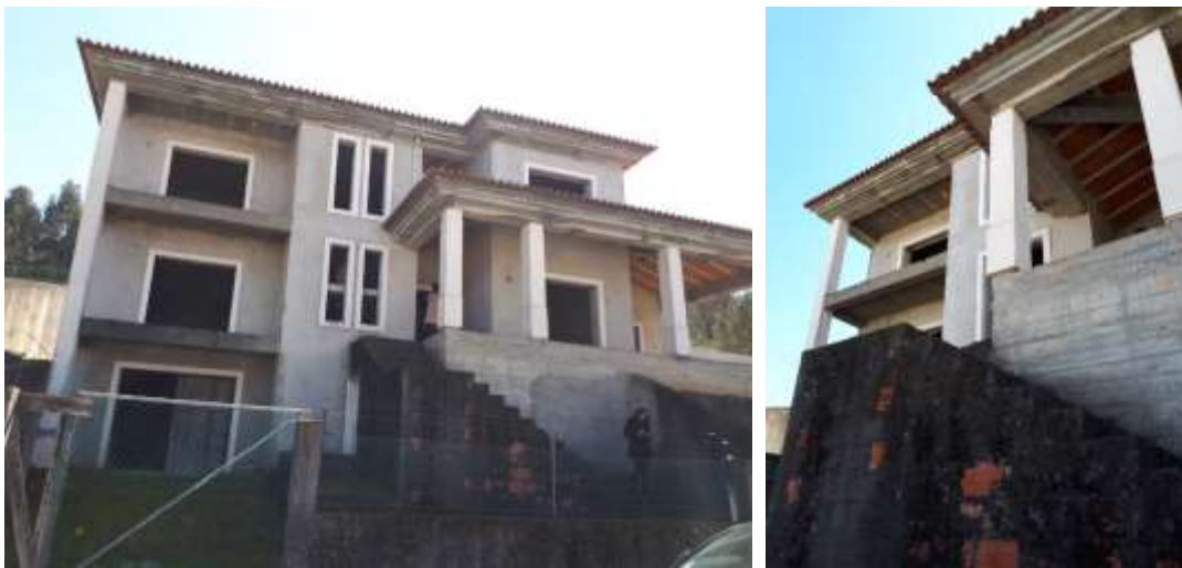
Figura 200. Fotografias da habitação em obra. Fonte: Diamantino Figueiredo.
