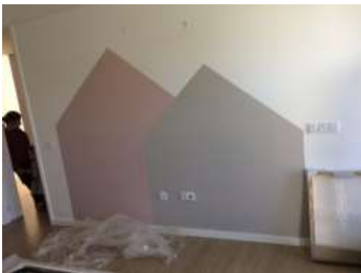
Figura 47. Processo de montagem - pintura de parede. Fonte: Autor.
