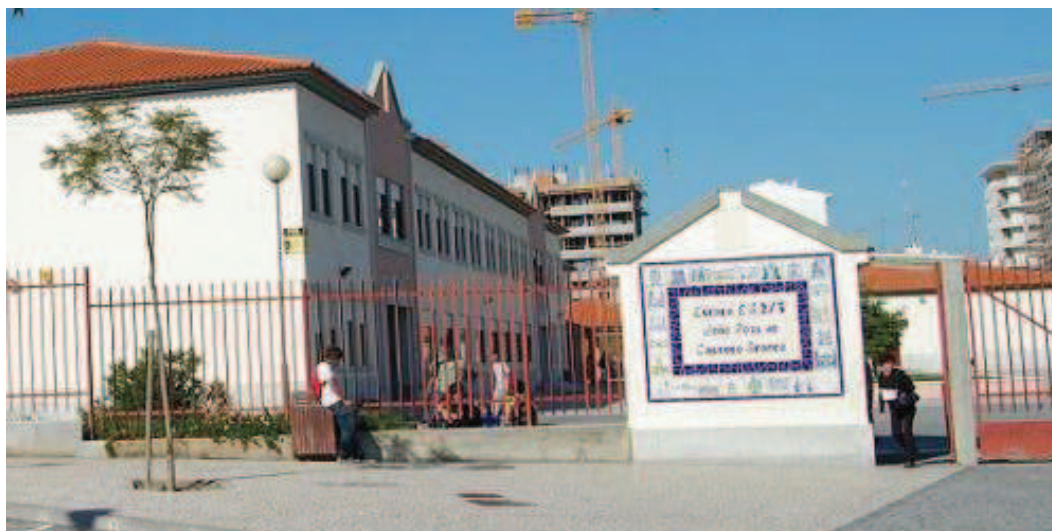
Imagem 7 - Edifício da Escola Básica Integrada João Roiz de Castelo Branco.
