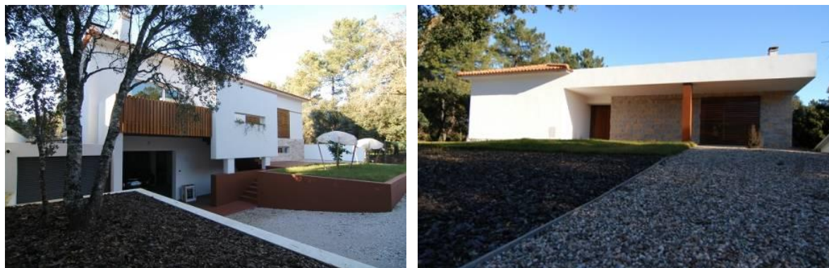
Figura 42 - Levantamento fotográfico actual e planta do 3º piso
