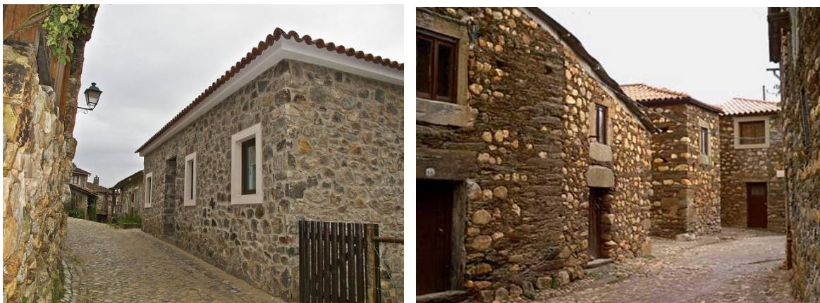
Figura 126- Fotografias do exterior do casario tradicional reconstruido e preservado (Fonte: http://www.aldeiasdoxisto.pt )
