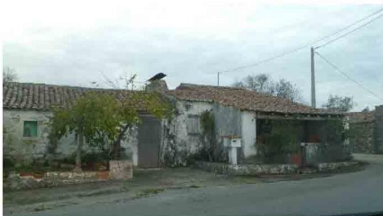
Figura 133 - Habitação com alpendre de Pial, alpendre com vigas de madeira que suportam a extensão do telhado da habitação
