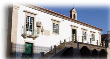
Figura 5 Edifício do Centro de Interpretação do Bordado
