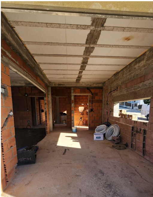
Figura 22 - Fotografia em obra cozinha (Projeto AP). Fonte: Autora
