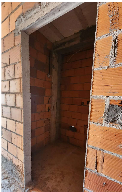
Figura 16 – Fotografia em obra W.C Social (Projeto AP). Fonte: Autora.
