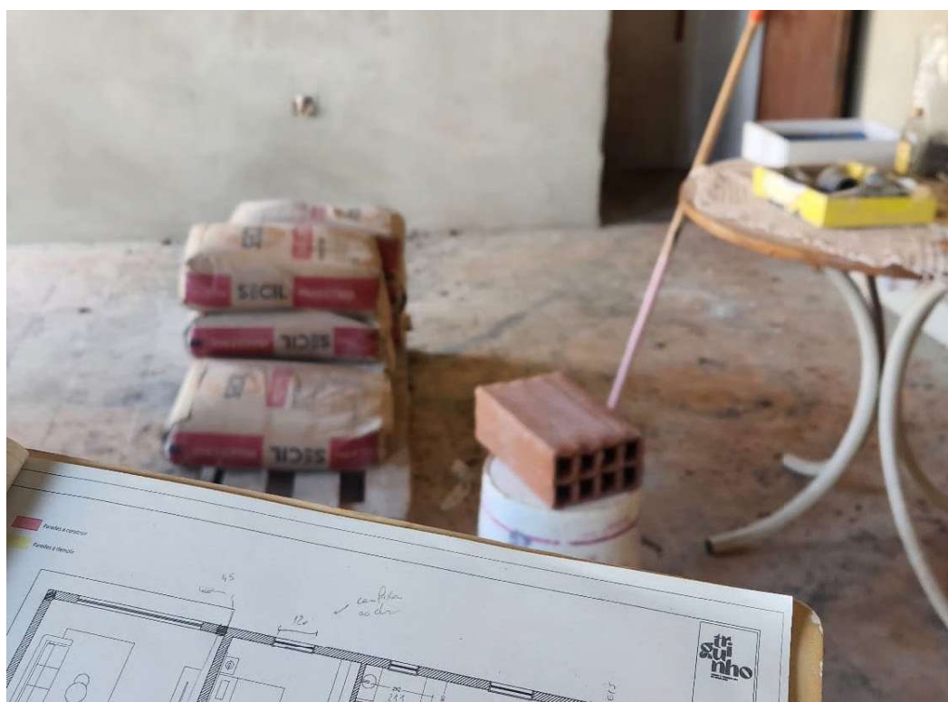
Figura 34 - Foto de levantamento dimensional em obra (Projeto VM). Fonte: Autora
