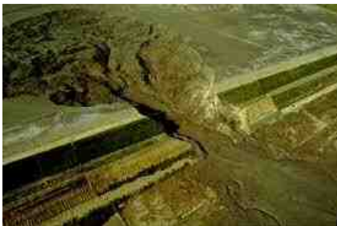
Figura 5 - Acidente de Aznalcollar, Espanha, 1998 (Fonte [33])
