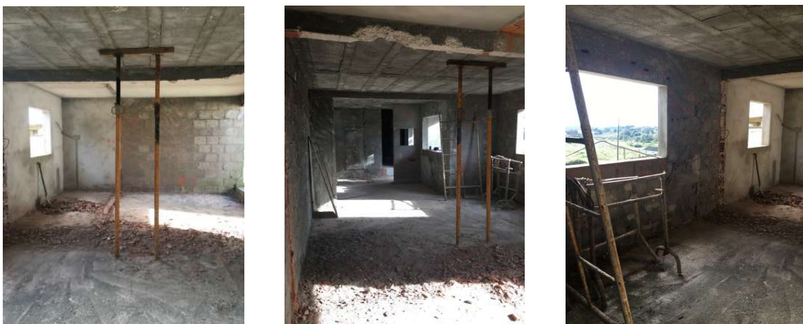
Figura 51 - Levantamento fotográfico da obra
