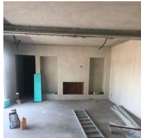
Figura 55 - Acompanhamento de obra
