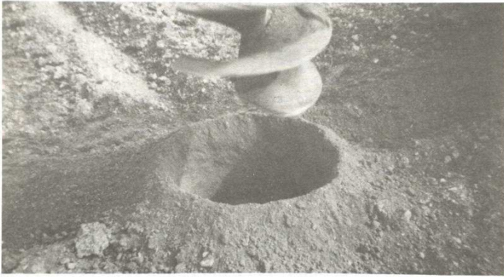
FOTO 13 - Abertura da cova com Broca (L.Garcia)
