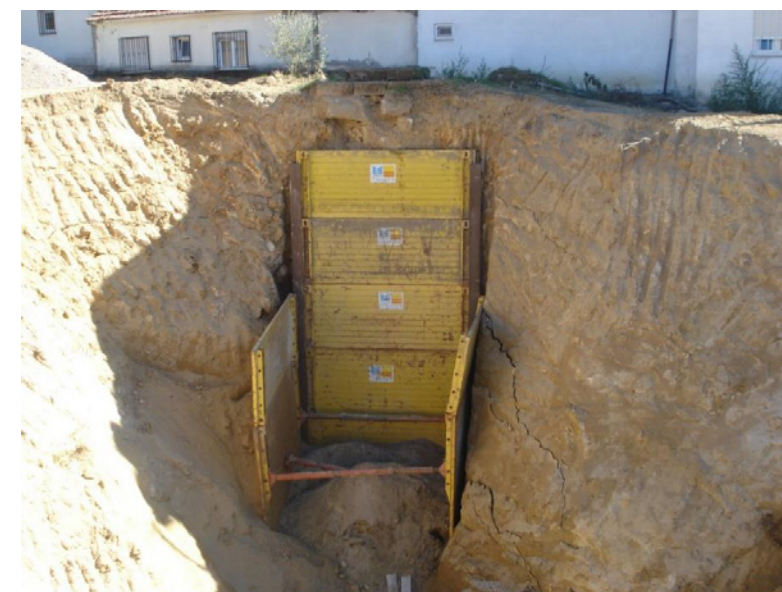
Figura 1. Contenção provisória.
