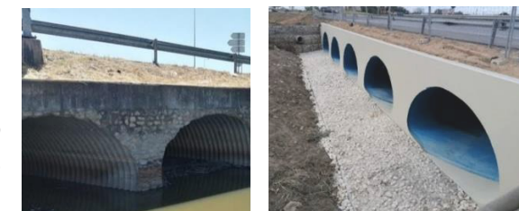
Figura 3 – Comparação entre o estado inicial e final da PH, após a reabilitação GFRP acompanhada
