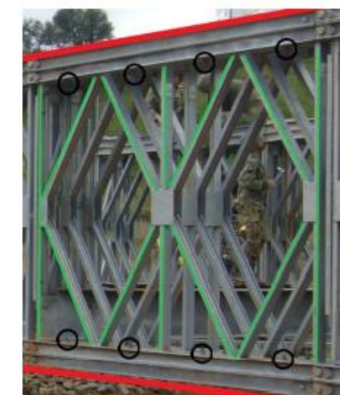
Figura 2. Reforços/alterações representadas num painel-tipo
