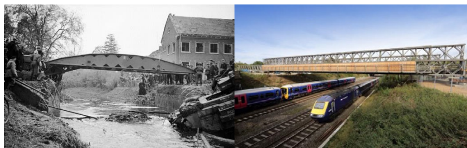
Figura 1. Ponte montada na 2ª Guerra Mundial na Alemanha (esquerda), e Ponte Mabey Compact 200 montada no Reino Unido (direita) [1].
