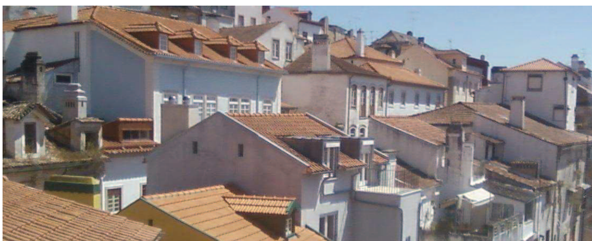
Figura 77 – Imagens de coberturas da rua Fernandes Tomás.
