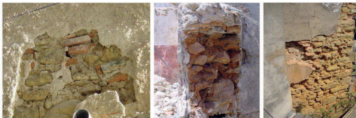
Figura 30 – Alvenarias de pedra irregular na Baixa de Coimbra [Vicente, 2008].
