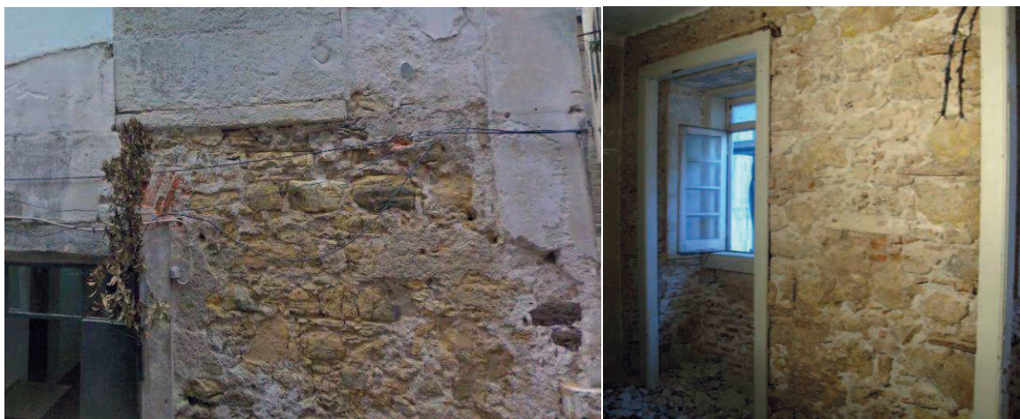
Figura 58 – Exemplos de paredes das fachadas principais alvenaria de pedra.
