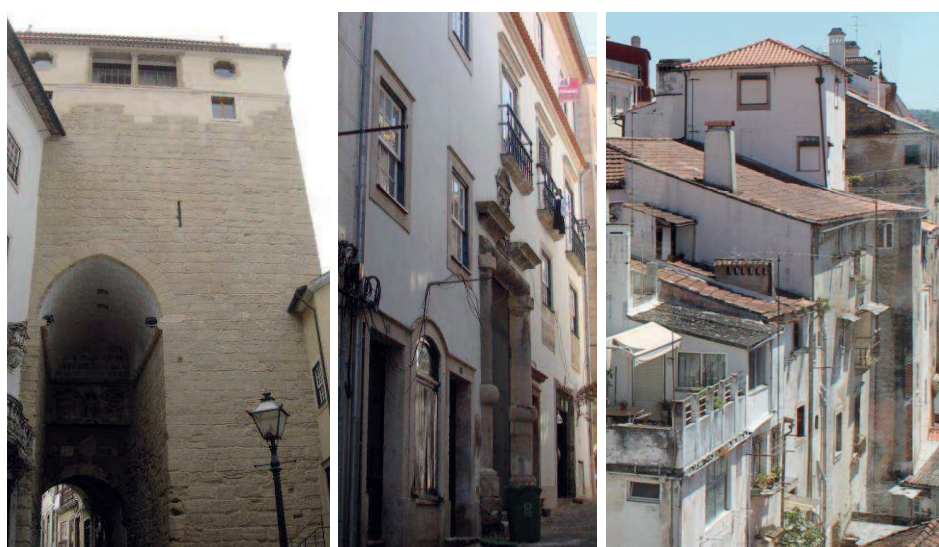
Figura 40 – Imagem da Torre de Almedina e da Casa das Fangas; localização da Torre do Trabuquete.
