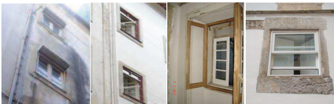
Figura 95 – Reabilitação de vãos envidraçados: eliminação de caixas de estore e exemplos de aplicação de 2º caixilho e de vidros duplos com substituição de caixilho.
