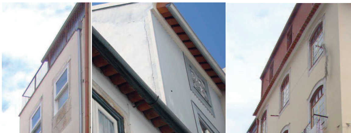
Figura 68 – Imagens de revestimentos da fachada em chapa metálica ao nível do último piso.
