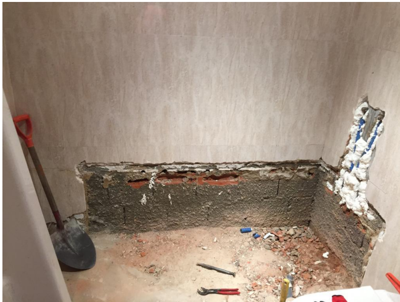
Figura 176 - Fotografia da remoção da banheira.
