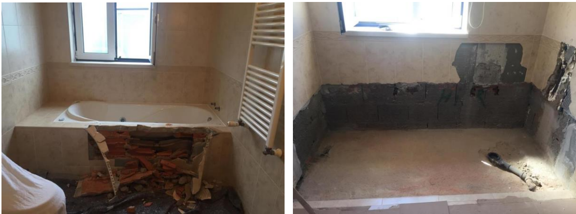
Figura 161 - Fotografia dos trabalhos de demolição.
