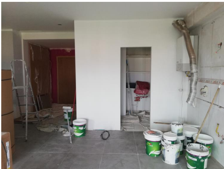
Figura 144- Fotografia da execução da despensa.
