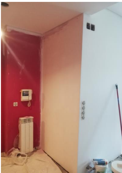
Figura 139- Fotografia da parede que continha a porta de acesso do corredor para a cozinha.
