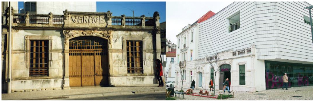
Figura 11 - O antes e depois do Edifício Garage (o alçado principal manteve as duas janelas e o portão). Fonte: Cores de Leiria e Diário de Leiria .
