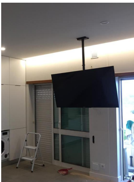
Figura 141- Fotografia da parede com sanca luminosa.
