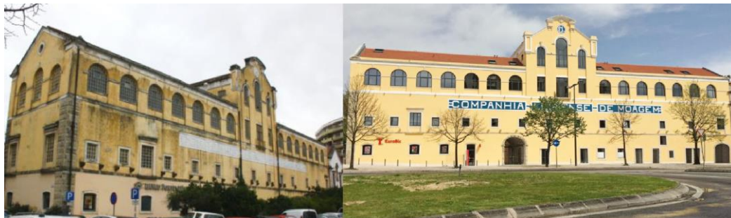
Figura 12 - O antes e depois do Edifício Moagem , conhecido neste momento como o Edifício Heritage (o alçado principal e lateral do Edifício manteve-se).
