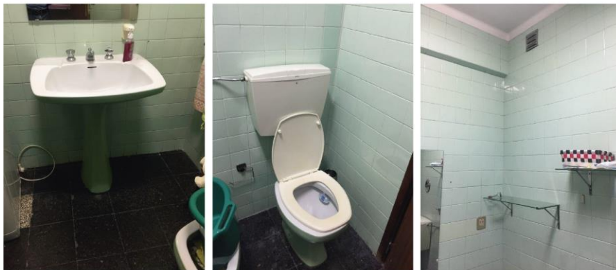
Casa de banho nº2
