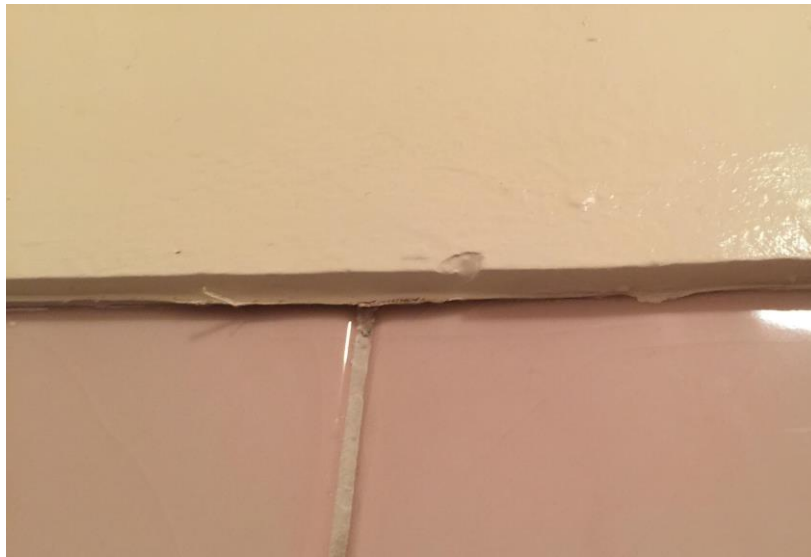
Figura 168 - Fotografia da saliência existente entre o cerâmico e a parede com reboco.
