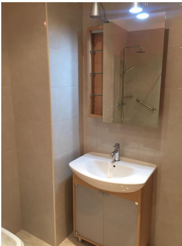
Figura 180- Fotografia do novo revestimento com o Lavatório existente.
