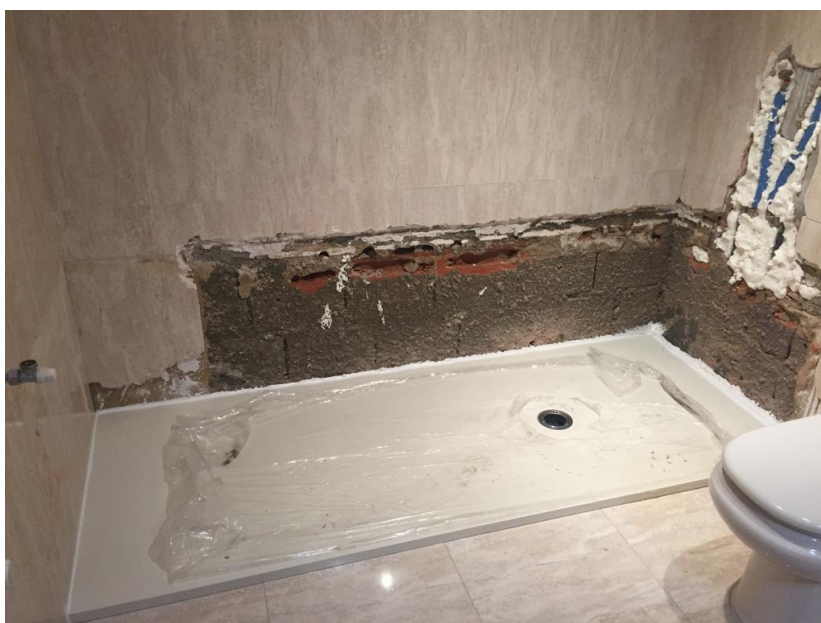
Figura 177 - Fotografia da colocação da base de duche durante a obra.
