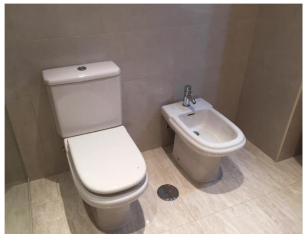
Figura 181- Fotografia das louças sanitárias existentes com o novo revestimento.
