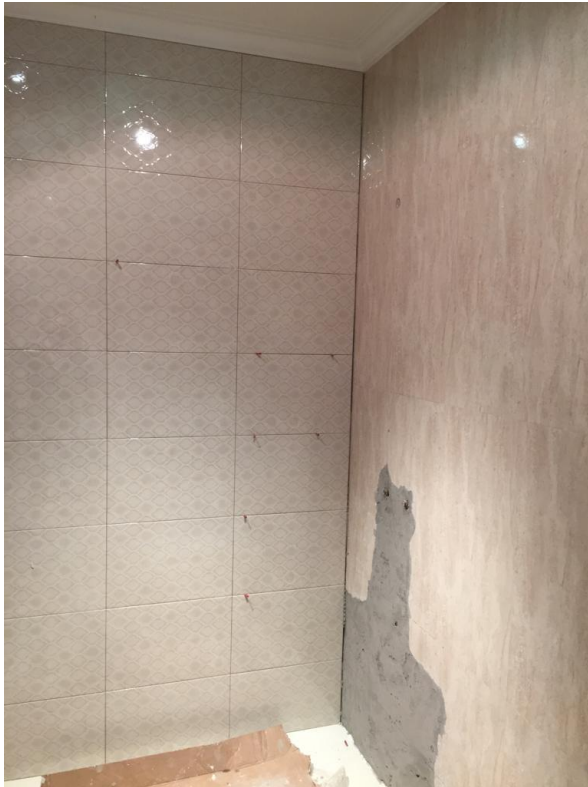
Figura 178- Fotografia durante a aplicação do revestimento.
