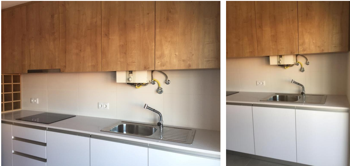
Figura 115- Fotografias da cozinha com o cerâmico e a bancada em silestone.
