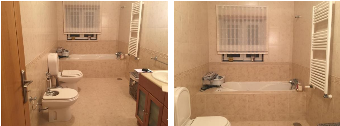
Figura 157 - Fotografias da casa de banho a intervencionar.
