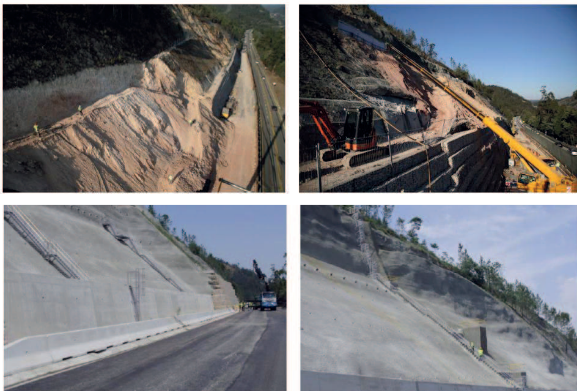
Figura 3-9 - Fase de obra. Antes e depois da intervenção (Cenor).
