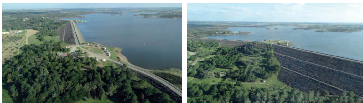
Figura 3-28 - Barragem do Monte da Rocha (fonte: portugalfotografiaaerea.blogspot.pt)
