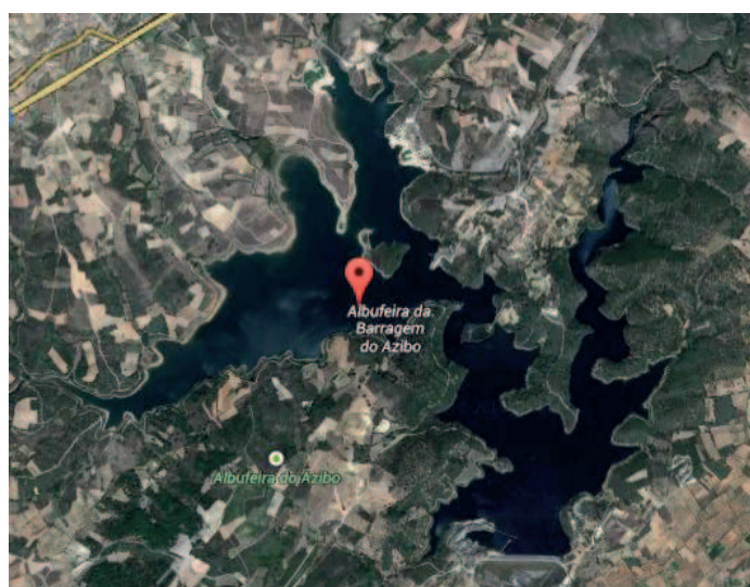
Figura 3-33 - Barragem do Azibo (fonte: Google maps).
