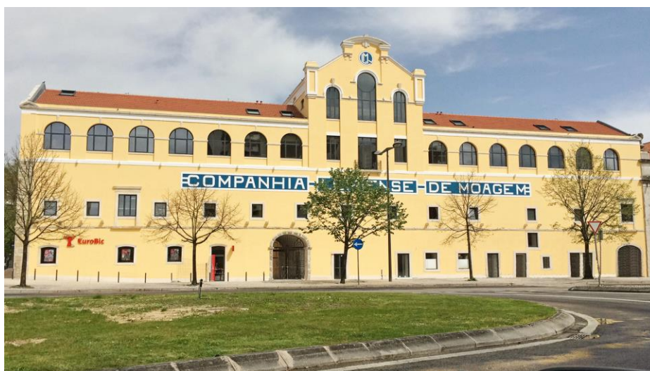
Figura 8. Edifício da Moagem, Leiria, fonte: António García Arquitectos
