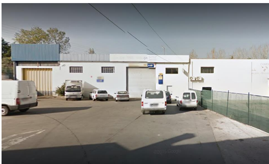
Figura 44. Oficina- fachada existente, fonte: google maps
