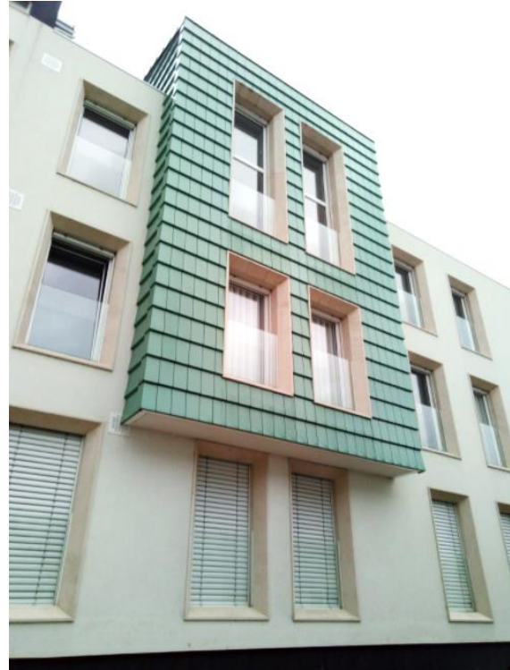
Figura 52. Fachada do edifício 3 Bicas, fonte: autora
