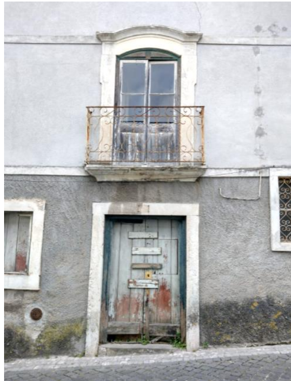
Figura 1. Fachada característica do centro histórico de Leiria, fonte: autora
