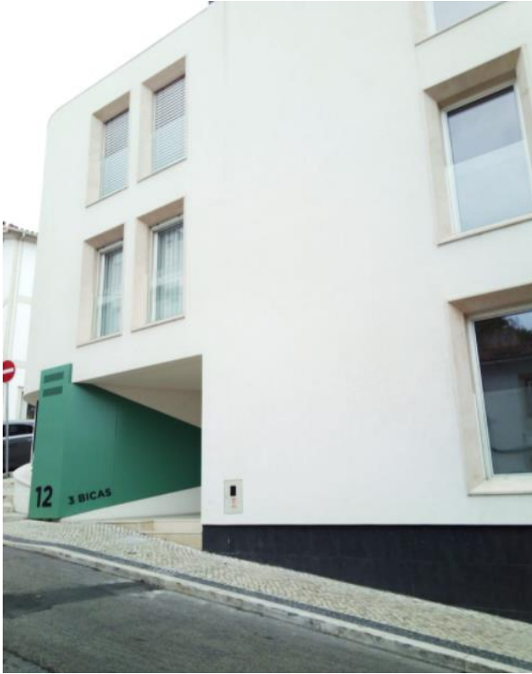
Figura 51. Fachada do edifício 3 Bicas, fonte: autora
