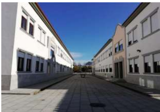
Figura 23 Entrada do bloco do 1.º CEB
